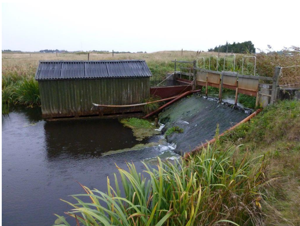
Figur 1.3 AAL-1129. Ålekiste, der er beliggende på den udpegede strækning til restaurering.
